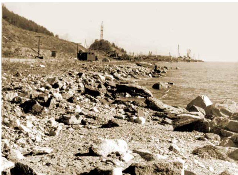
Рис. 3. Волногасящая берма протяженностью 570 м; 1083 км ВСЖД. Сентябрь 1985 г. Фотография Г. Г. Зубаренковой
