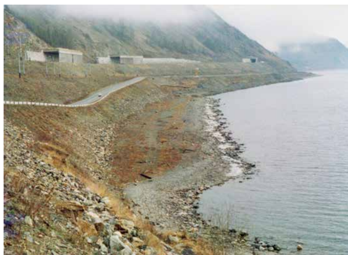
Рис. 2. Волногасящая берма протяженностью 460 м; 1066–1067 км ВСЖД. Сентябрь 1988 г. Фотография Г. Г. Зубаренковой
