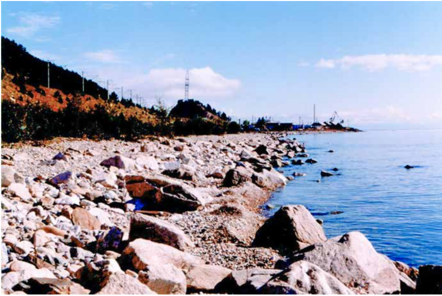
Рис.4. Волногасящая берма протяженностью 570 м; 1083 км ВСЖД. Сентябрь 1999 г. Фотография Е.К. Гречищева
