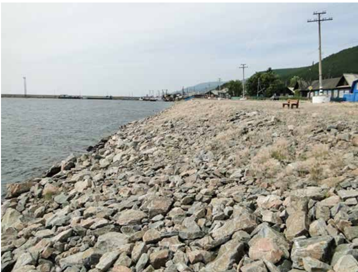
Рис. 7. Участок берега после строительства бермы, 2013 г. Фотография В. А. Петрова
