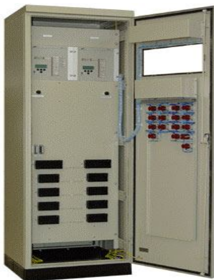
Рис. 4. Шкаф ШЭ2607 022 предназначен для дистанционной и токовой защит обходного выключателя [1]
