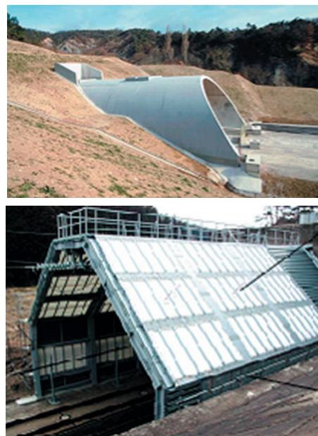
**Рис. 11. Выносные порталные конструкции из монолитного железобетона с атмосферными каналами и из композитных материалов**
